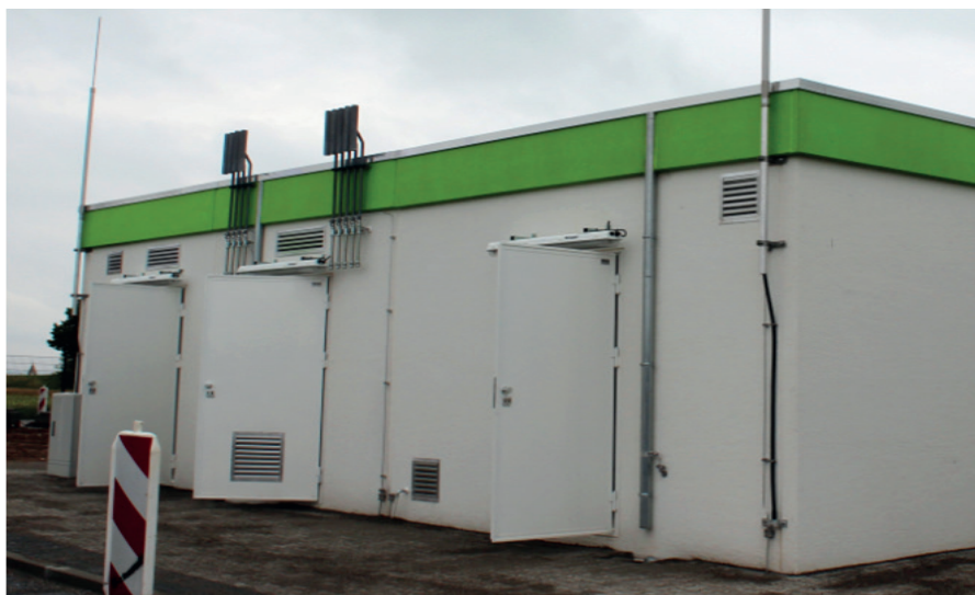
Abb. 7: Montaż przewodu isCon® na masztach w biogazowni.
